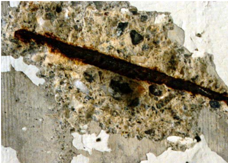
Eclat du à la carbonatation
